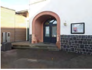
Stufen im Eingangsbereich
